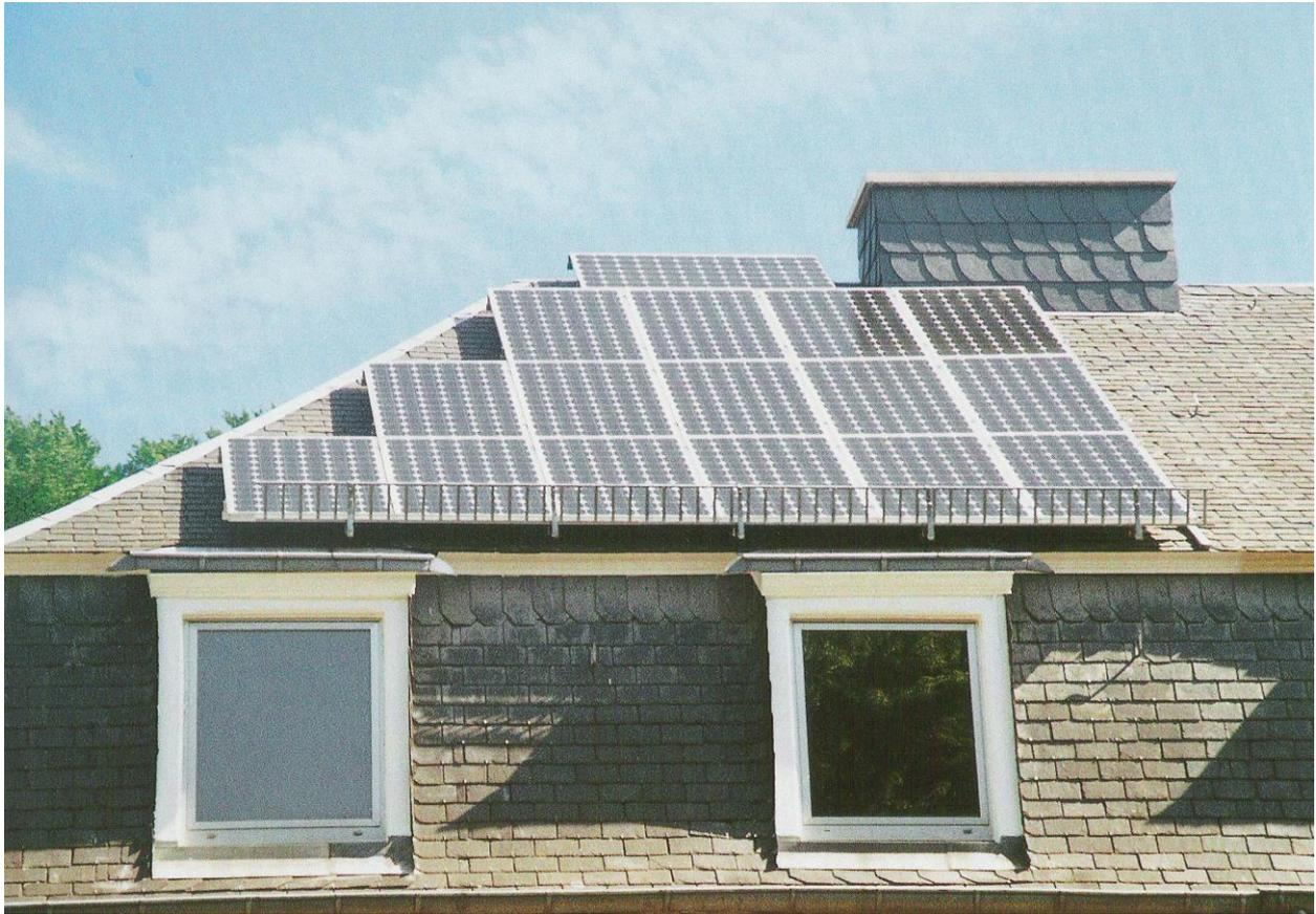
*Abb.: 2,8-kWp-Photovoltaik-Anlage (Foto: S. Brocker)*
